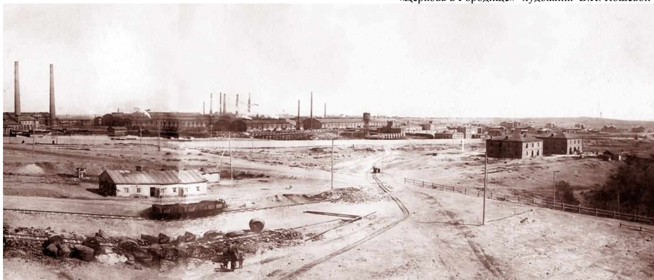
Юрьевский завод (станция Юрьевка – «Алчевское» на Екатерининской железной дороге), нач. XX века.
