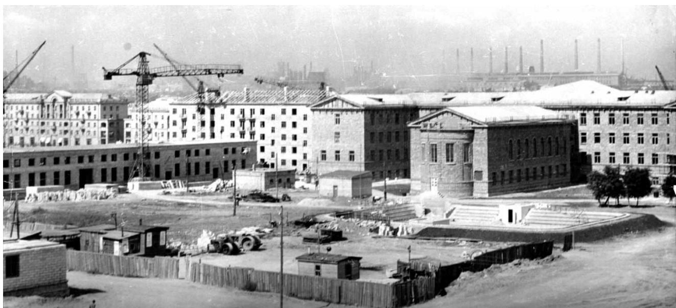
Строительные работы на улице Фрунзе, 1960-е годы.
