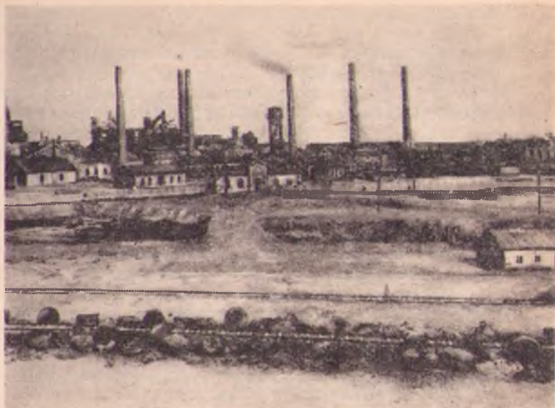
Общий вид завода дореволюционного периода.
