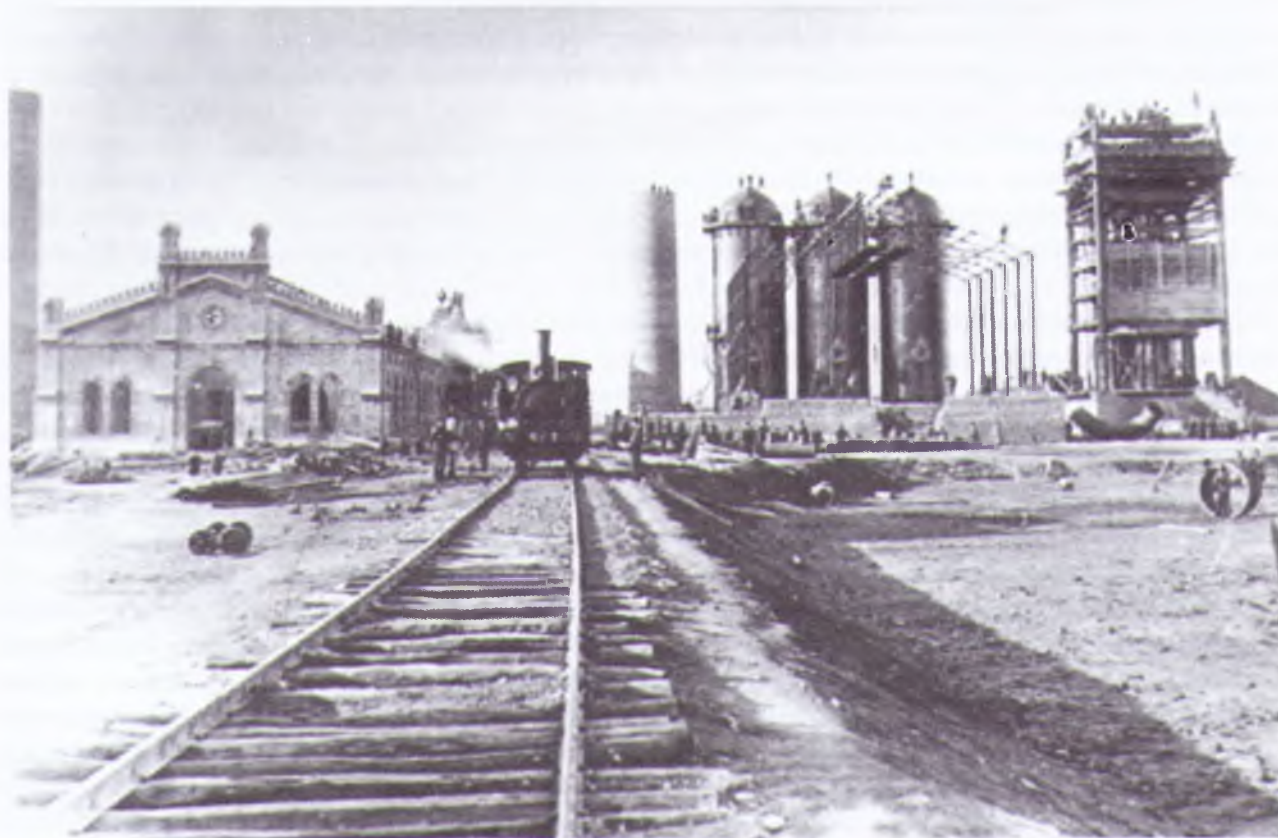
Строительство завода ДЮМО — сталелитейный цех
