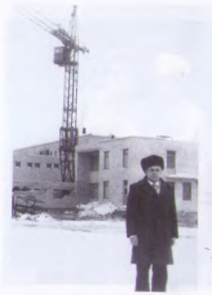
В.А.Боровенский возле строящегося объекта. Фото 1985 г.
