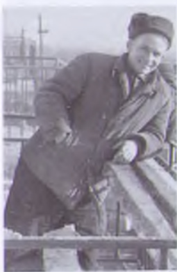
В.А. Боровенский на стройке, плотник. г.Алчевск. (Фото 1958 г.)
