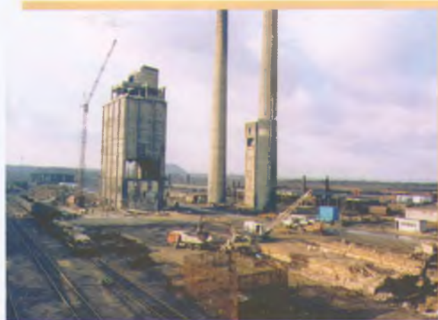
Идет реконструкция коксового цеха № 3
