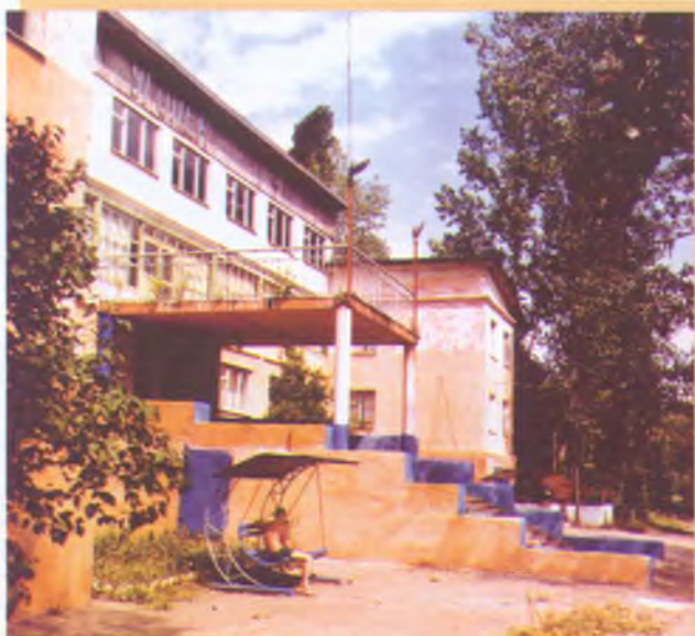
База отдыха «Уголек» углеподготовительного цеха № 1
