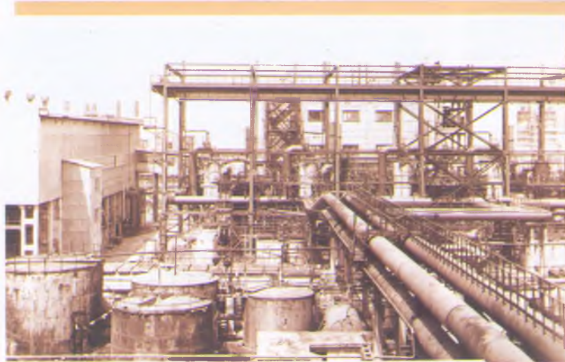
Реконструкция цеха улавливания № 2. 1987 г.
