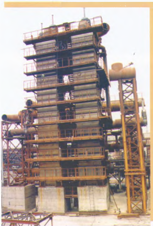
В комплексе работ по реконструкции коксовой батареи 10-бис коксового цеха № 3 в начале 2004 года начаты работы в цехе улавливания на трубчатых газовых холодильниках
