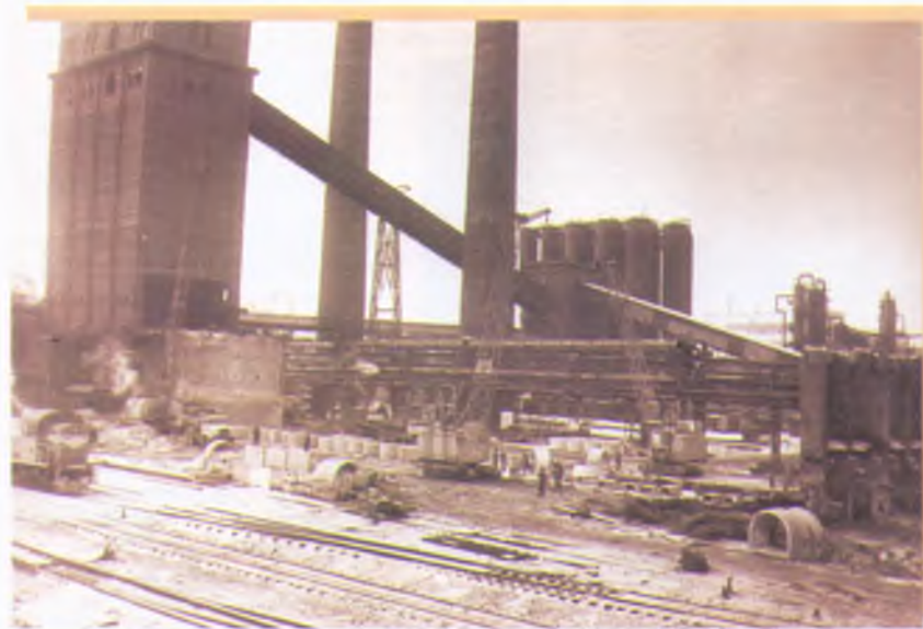
Идет реконструкция коксового цеха № 2
