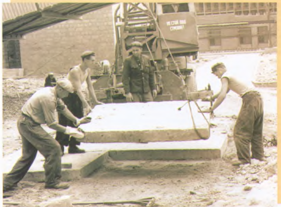
Ударно трудятся строители на реконструкции коксового цеха № 2
