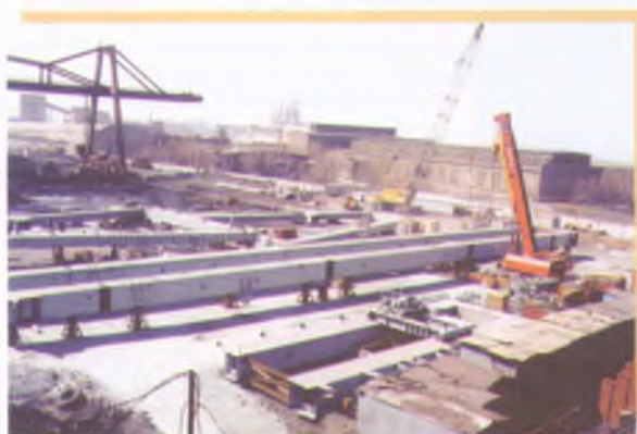
Монтаж крана-перегрузателя в углеподготовительном цехе № 1
