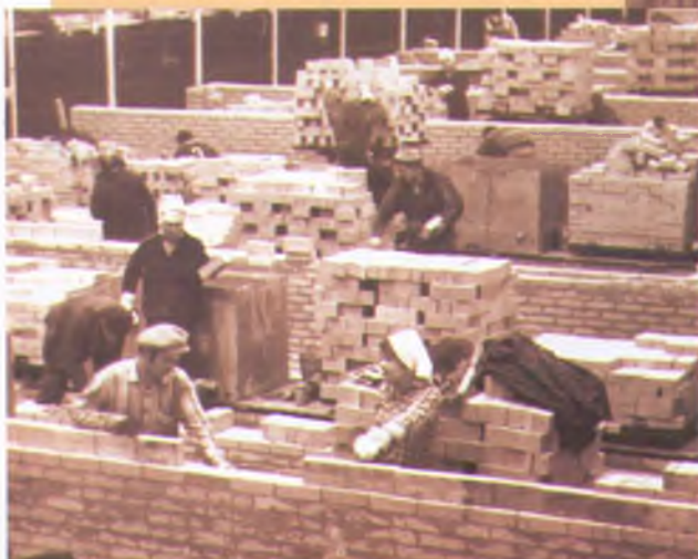
Каменщики-огнеупорщики старательно выполняют свою работу. Коксовая батарея № 5 коксового цеха № 2 растет не по дням, а по часам.
