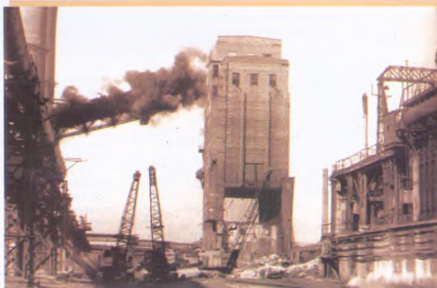
Запланированный взрыв коксовой башни коксового цеха № 3, что значительно ускорит ход строительно-монтажных работ по реконструкции цеха
