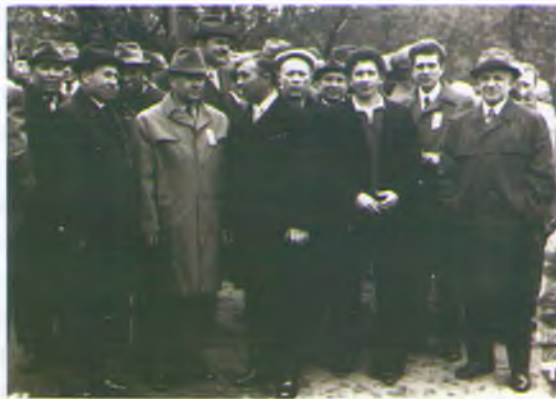
Механик цеха В.Бычек с ремонтной службой цеха.
