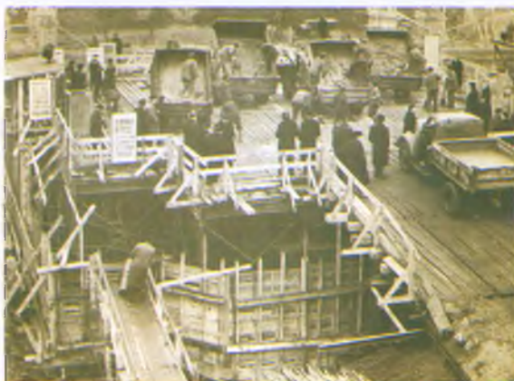
Закладка фундамента ДП №5 (1959 г.)
